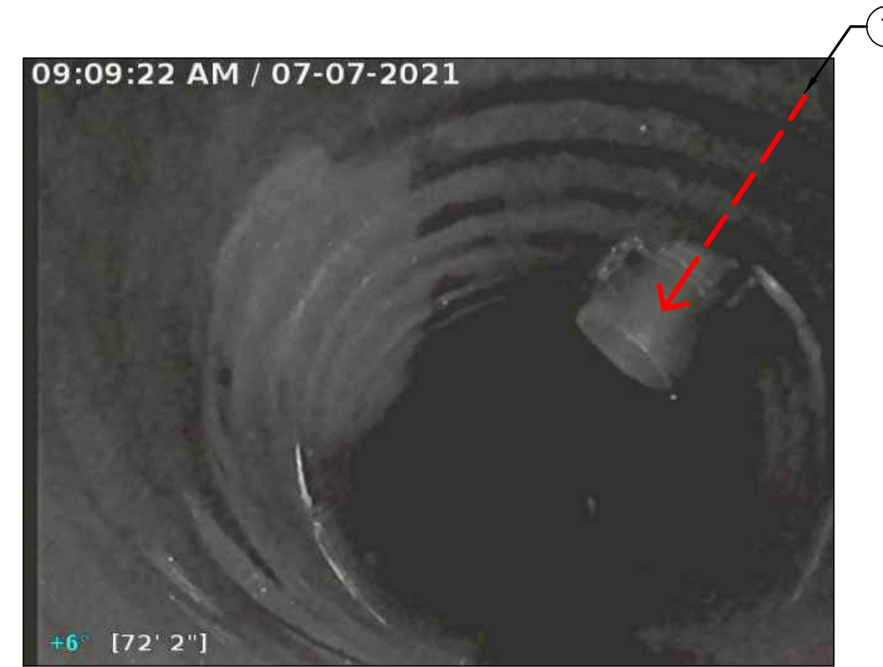
PHOTO 4 SERVICE CONNECTION FROM 12116 SE NELLA WAY
