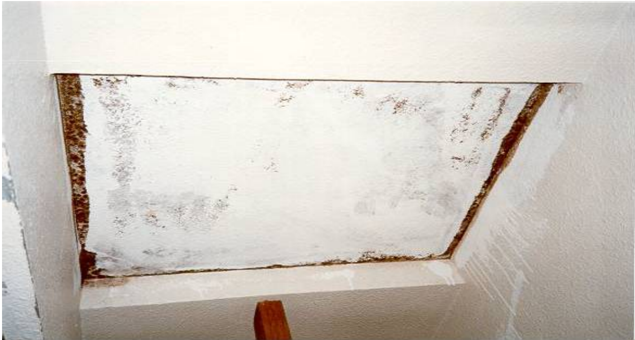
Figura 13. Los paneles de pared cubiertos de moho deben quitarse con cuidado. Aplicar pintura sobre moho no es una práctica aceptable de trabajo.
